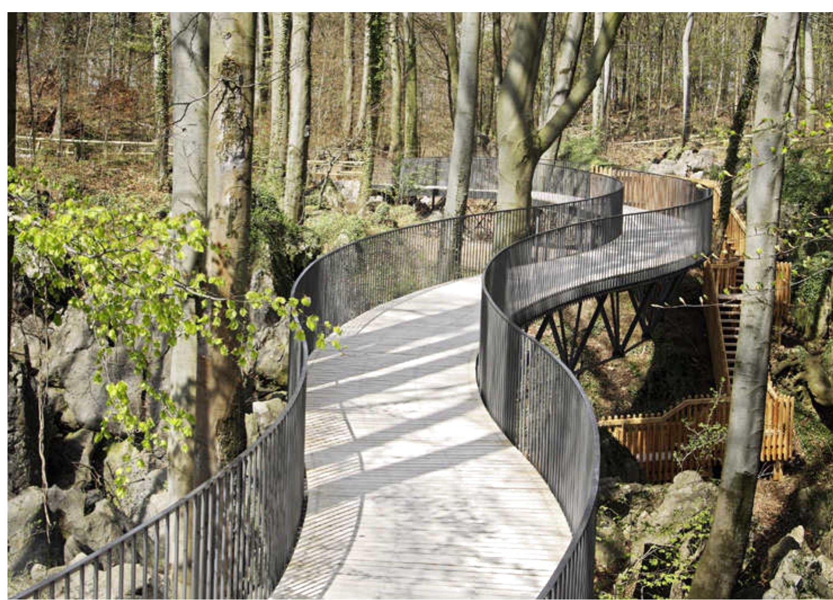
Fußgängerbrücke Felsenmeer Hemer
